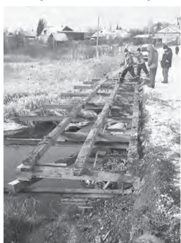
Работники ООО «Аятлес» приступили к капитальному ремонту моста
