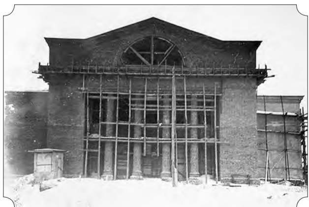
Строительство Дворца культуры машиностроителей
