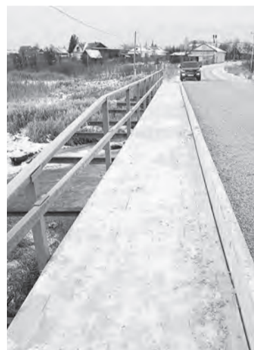
А вот таким стал пешеходный мост через реку Аят после реконструкции
