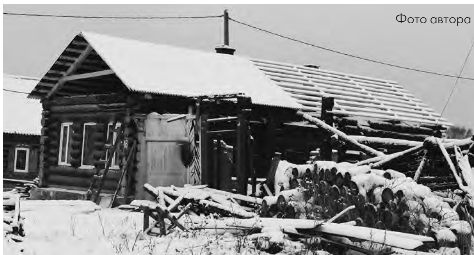
Дом в селе Шурала после пожара
